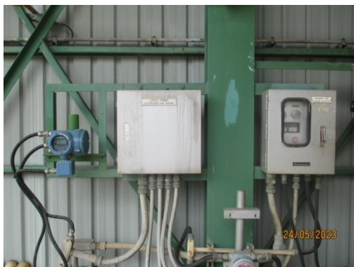
รูปที่ 3.2-65 Chlorine Gas Detector
