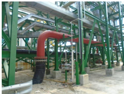
รูปที่ 3.2-72 ระบบเชื่อมต่อน้ำดับเพลิงระหว่าง
