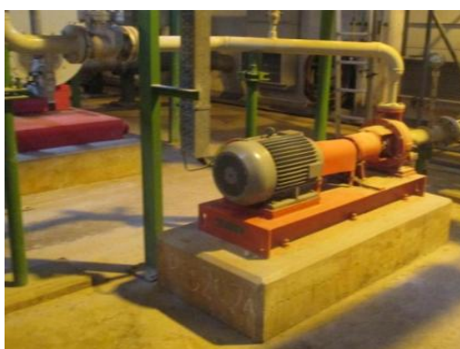
เครื่องสูบน้ำเพิ่ม/รักษาแรงดัน (Jockey Pump)
