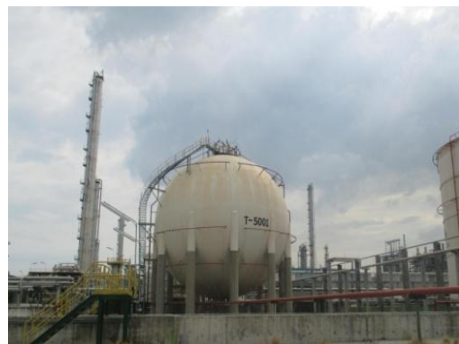
รูปที่ 3.2-53 ถังเก็บผลิตภัณฑ์ Double Wall และคั่นคอนกรีต
