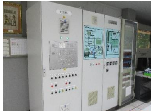
รูปที่ 3.2-60 ระบบตรวจสอบอัตราการไหลและความดันก๊าซ
