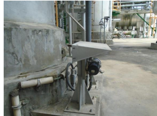
รูปที่ 3.2-45 Gas Detector
