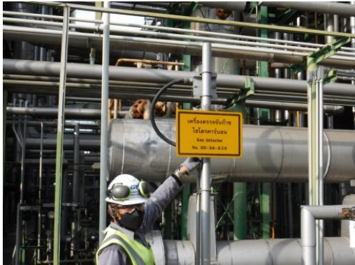
รูปที่ 3.1-35 ระบบตรวจจับเพลิงไหม้และก๊าซ
