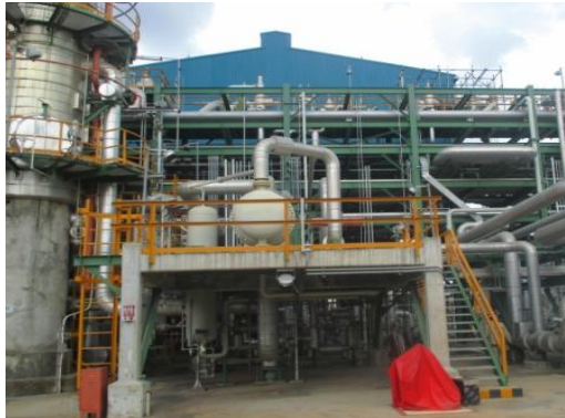
รูปที่ 3.2-50 Concrete Fireproofing
