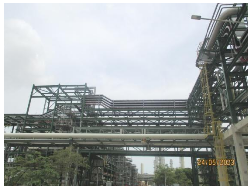
รูปที่ 3.2-63 ติดตั้งท่อรับวัตถุดิบก๊าซหนัก (Heavy Gas) จากโรงอะโรมาติกส์และโรงกลั่นน้ำมัน
