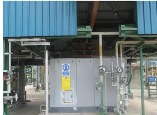
รูปที่ 3.2-34 ฝาท่อเครื่องจักรเพื่อลดระดับเสียง จากแหล่งกำเนิด
