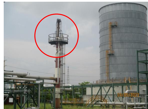
รูปที่ 3.2-4 Low Pressure Flare
